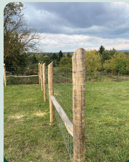
TORNADO TITAN OPTIMUM angol gyártmányú, csúszásmentes csomózású TL15/155/15 vadhálóból készült kerítés. A sarok és töréspontokon a rendkívül erős kitémasztások a tökéletes stabilitást szolgálják
