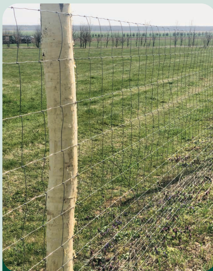
TORPEDO hagyományos hurkolt csomózású CE16/170/15 vadhálós kerítés. A kerítésmezőt érő fizikai hatásokra rugalmasan reagál, bármely körülmények között az elvárt védelmet nyújtja
