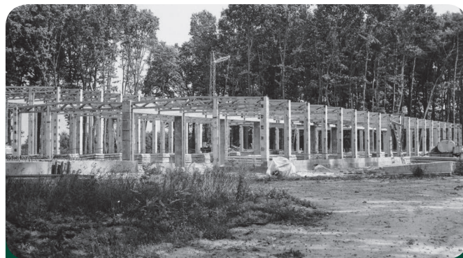
A munkacsarnok építése a Bajcsai Csemetekertben (1980).
