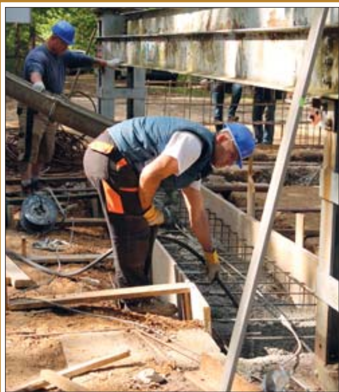
Megkezdődtek a mélyépítési munkálatok a Csónakázó-tó melletti kilátónál
