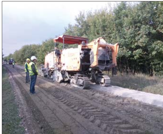
Finommarás Wirtgen hidegmaróval és vízbekeverés az előmárt, cementtel terített felületen
